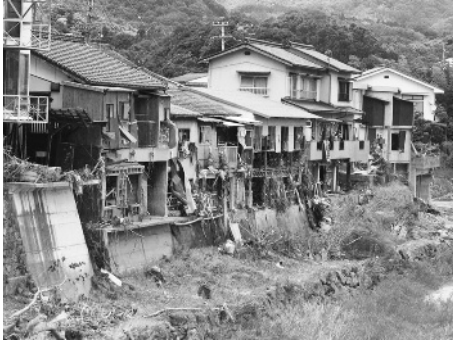
豪雨による被害
