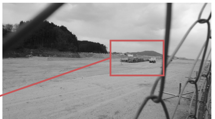
嵩上げ工事の様子
